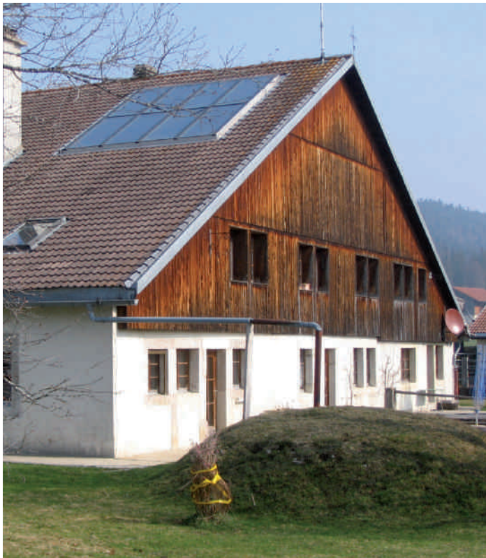
Ferme de Francine John Calame au Cerneux-Péquignot, rénovée avec panneaux solaires et récupération d'eau de pluie (sous la butte).
