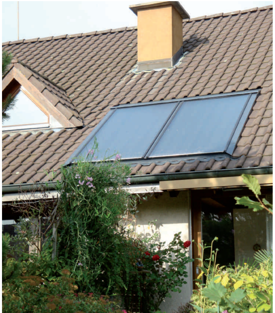
Il est préférable de ne pas installer des panneaux solaires au-dessus des endroits où on dort.
