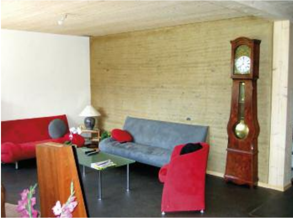
Maison Jaquier, enduits de finition en argile et mur en pisé, Kaspar architectes.
