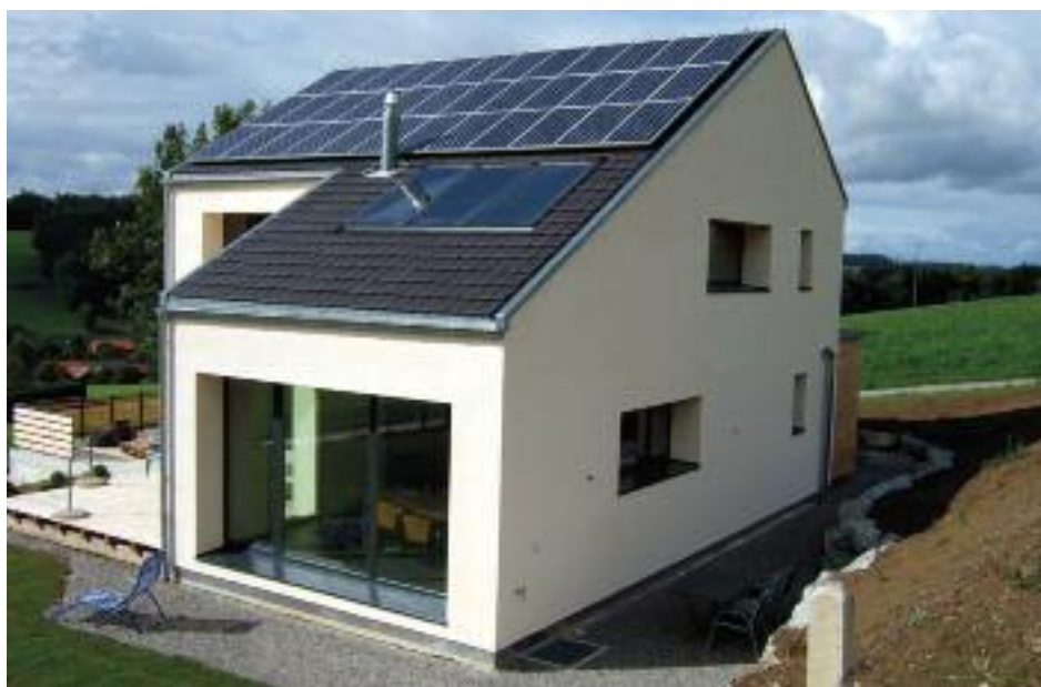
Maison en ossature bois et isolation paille, crépi extérieur à la chaux, Famille Jaquier à Prez-vers-Siviriez (FR), Kaspar architectes.
